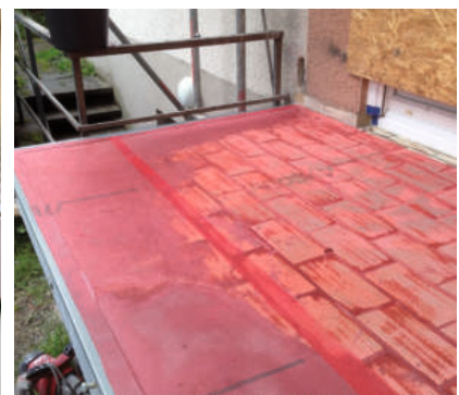
Einbau eines Armierungsgewebes
