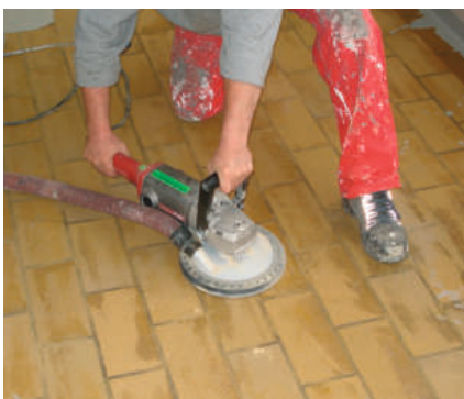
Vorarbeiten: Die Fläche wird gefräst
