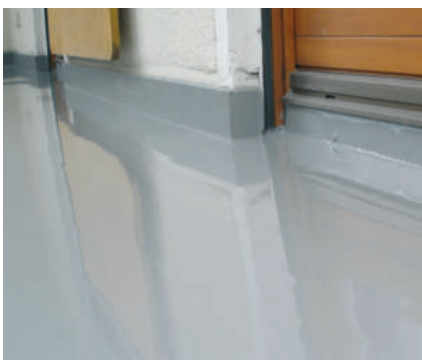
Dicht- und Nivellierschicht wird aufgebracht
