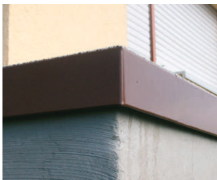
Tropfbleche werden eingebaut
