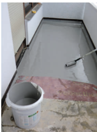
Dichtschicht mit Gewebeeinlage
