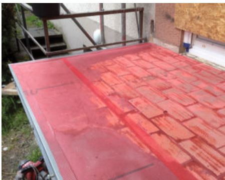
Einbau eines Armierungsgewebes
