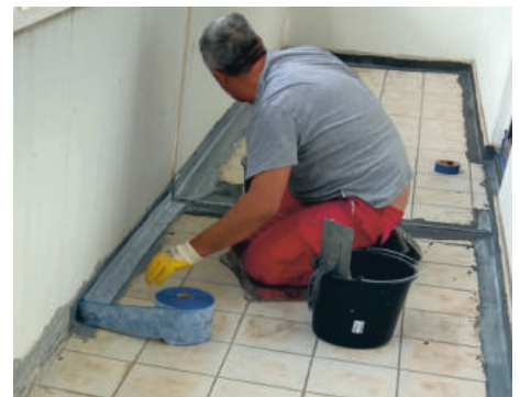
Sockelband wird eingearbeitet
