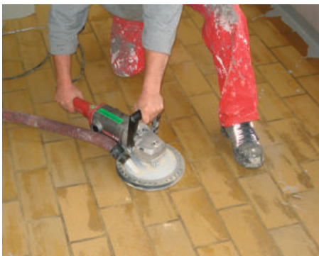
Vorarbeiten: Die Fläche wird gefräst
