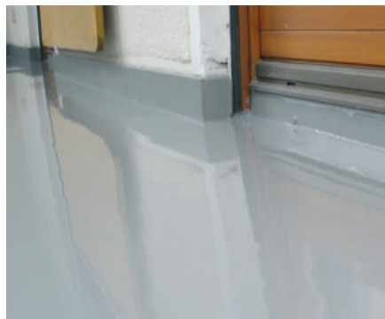
Grund- / Nivellierschicht wird aufgebracht
