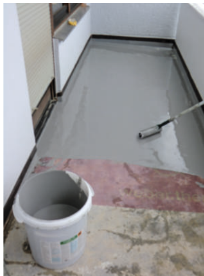
Nivellierschicht mit Gewebeeinlage
