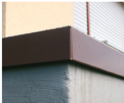
Tropfbleche werden eingebaut
