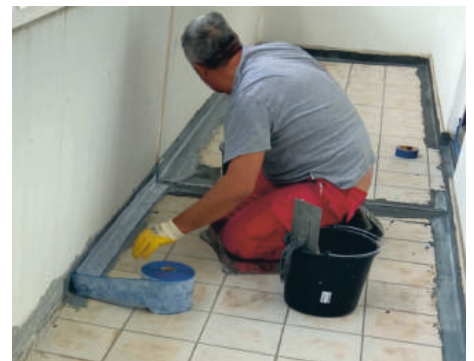
Sockelband wird eingearbeitet
