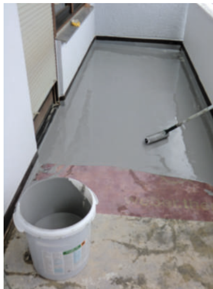
Nivellierschicht mit Gewebeeinlage
