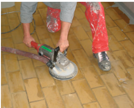
Vorarbeiten: Die Fläche wird gefräst
